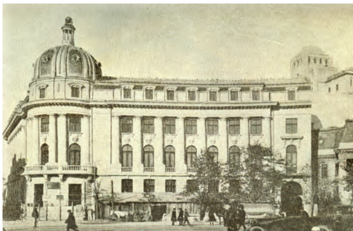
Figura 3.4 Clădirea AISCI înainte de inaugurarea din noiembrie 1926 (se observă încă împrejuririle din timpul construcției)
